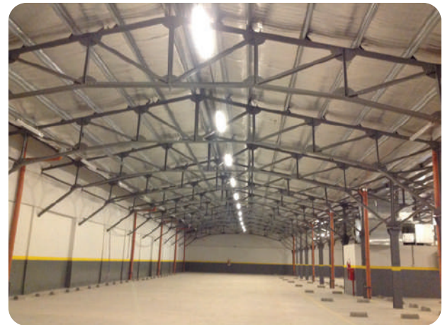
Fieltro tensado Alu colocado sobre malla plástica.
