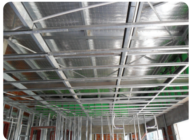
Utilización FielTRO Tensado Alu en cubierta.
